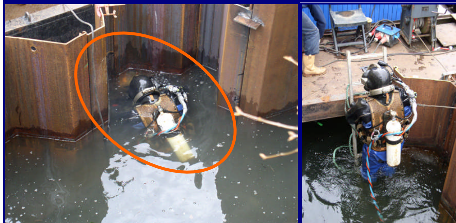
Unterwasserschweißen bei Temperaturen von 2 – 4 Grad.
