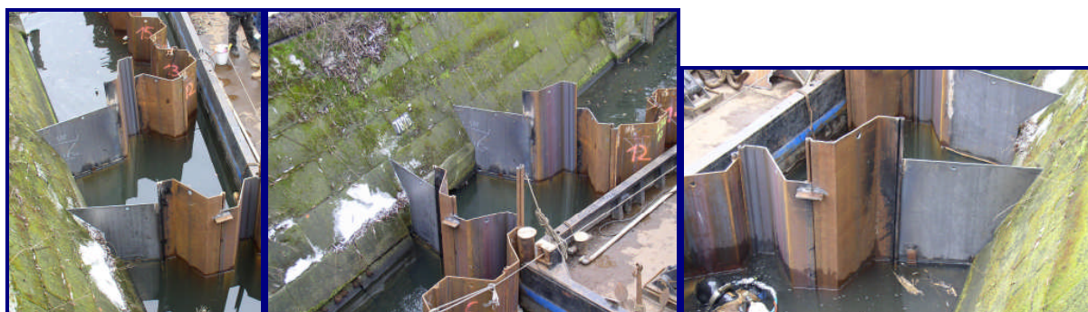
Fertiggestellter Auslauf am Tempelhofer Ufer aus unterschiedlichen Perspektiven (Quelle: alle Bilder WSA Berlin)
